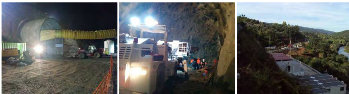
Figura 1 - Imagens das atividades construtivas relacionadas com o projeto na proximidade dos recetores R3, R12 e R13 – novembro de 2015.
